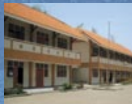
PEMBANGUNAN SEKOLAH DASAR SURABAYA
